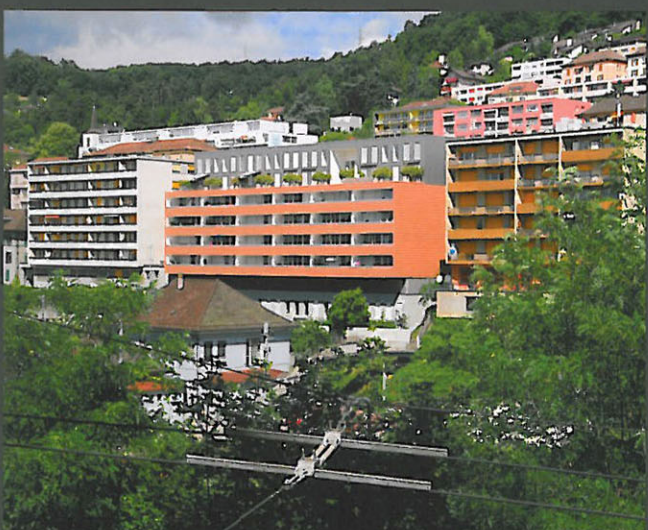
Immeuble d'habitation Les Parcs, Neuchâtel. Les Parc residential building, Neuchâtel.
