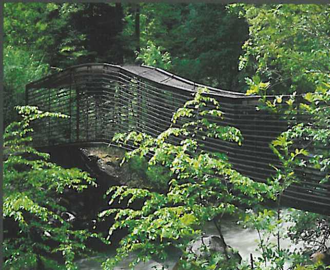
Passerelle sur l'Areuse, Gorges de l'Areuse. The walkway bridge over the Areuse and the Areuse Gorges.
